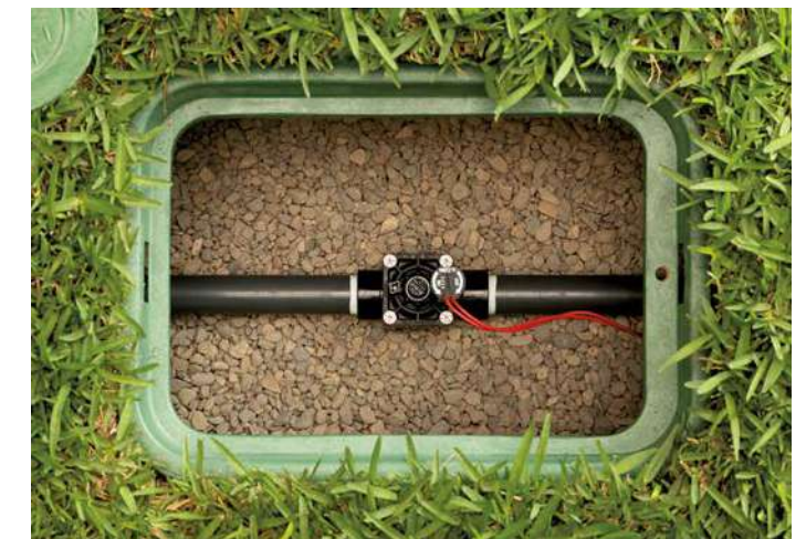
PGV-100G Ventile installiert
